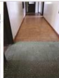
piso 2º andar as cerâmicas verdes são da parte nova e as terracotas da construção original
