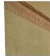
detalhe pintura especial
