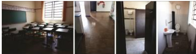
revestimentos segundo andar - parte original
