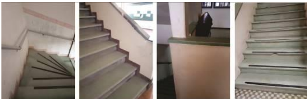
detalhes escada área ampliada década 60
